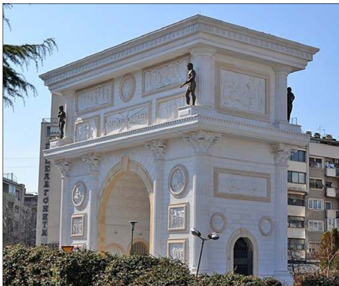
Egyik jelentős munkájuk Skopjében a Macedón Kapu újjáépítéséhez kapcsolódott
