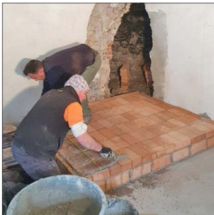
A talapzat és a nyílás a kéményre, Éliás Ádám, Árnyék nevű kuttyájával, Németh Mihály, Németh István és Orosz Örs. Elkészült az alsó szögletestömb
