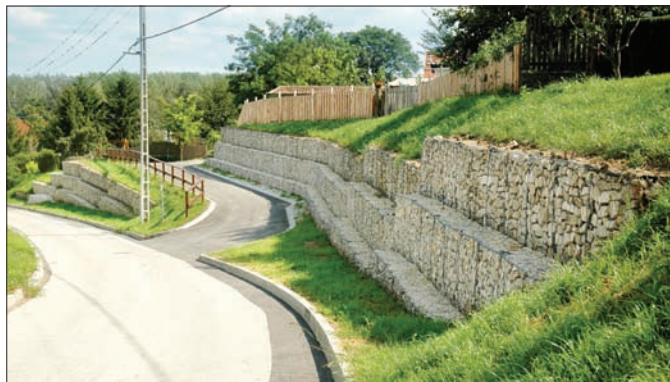
Partvédelem: Ófaluban folytatódott a partfal stabilizálása
