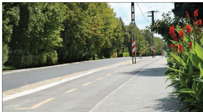
Útépítések: Felújítottuk az Arany János utcát, ahol megoldottuk a vízelvezetést és kerékpárutat is építettünk
